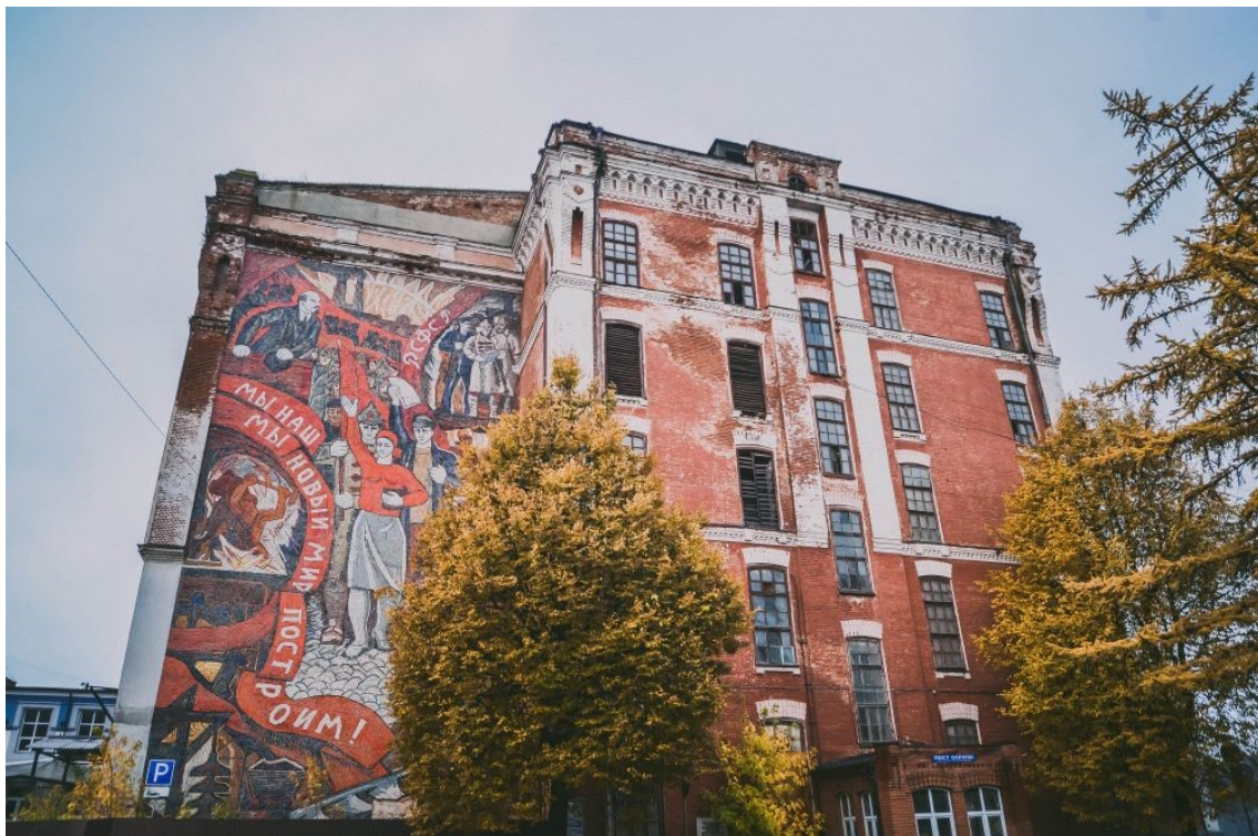
Op de gevel van het imposante hoofdgebouw de mozaïek met Lenin. Foto: Mei Architects and planners
