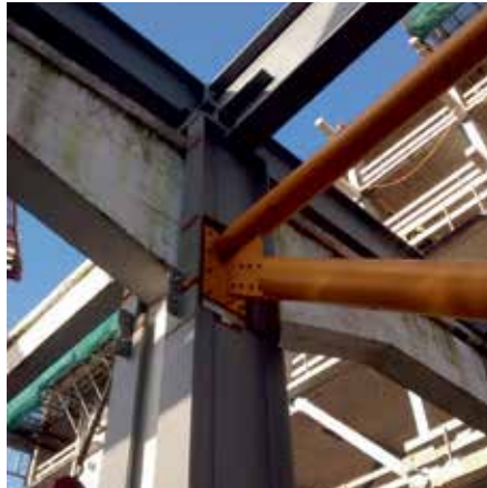
5. Versterking bestaande kolom.
