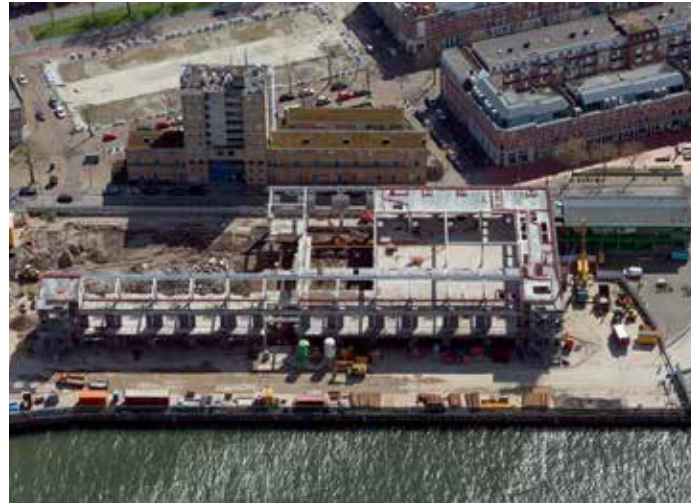
3. Gestript betonskelet bestaande loods.
