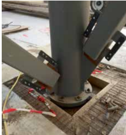
2. Typische aansluiting windbok-tijdelijke klesplaten.
