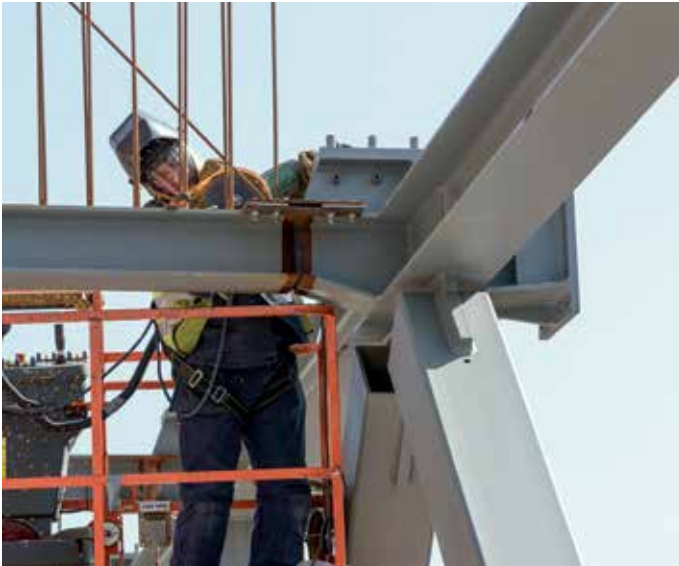
8. Aangelaste stekken voor overgang staal-beton.
